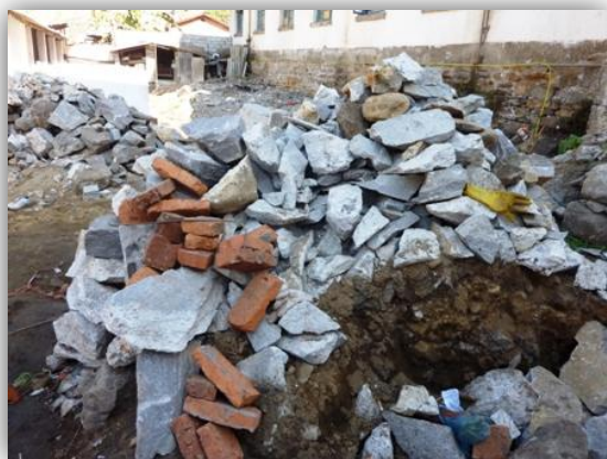
砕かれた石の残骸：簾誼小学校
