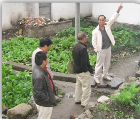
バイオガス施設の建設現場：籐誼小学校
