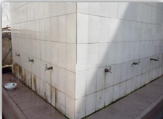
建設された貯水槽と手洗い場：簾誼小学校
