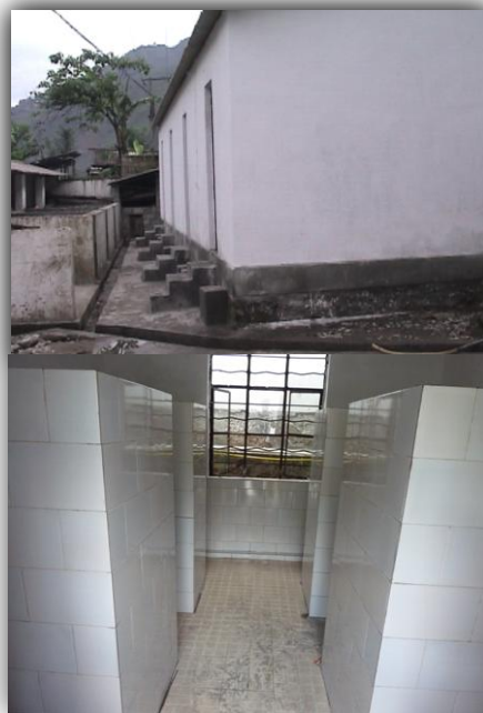
シャワー棟とシャワー室：簾誼小学校
